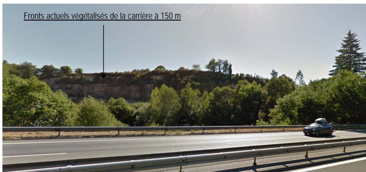
Figure 40 : Perception du site actuel depuis l'A20, au niveau d'une trouée sur le site
