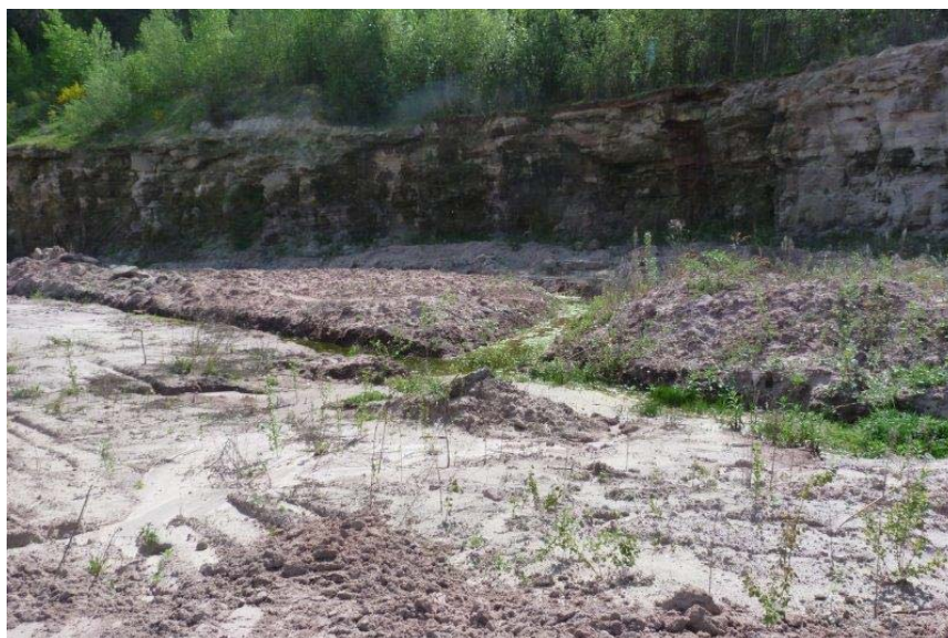
Figure 18 : Photographie du fossé aménagé en pied de front
