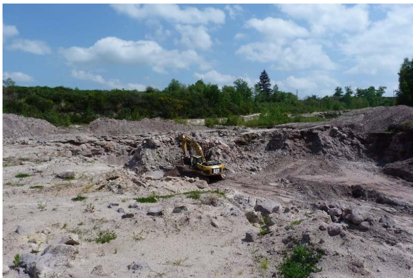
Figure 13 : Vue sur l'exploitation (avril 2018)
